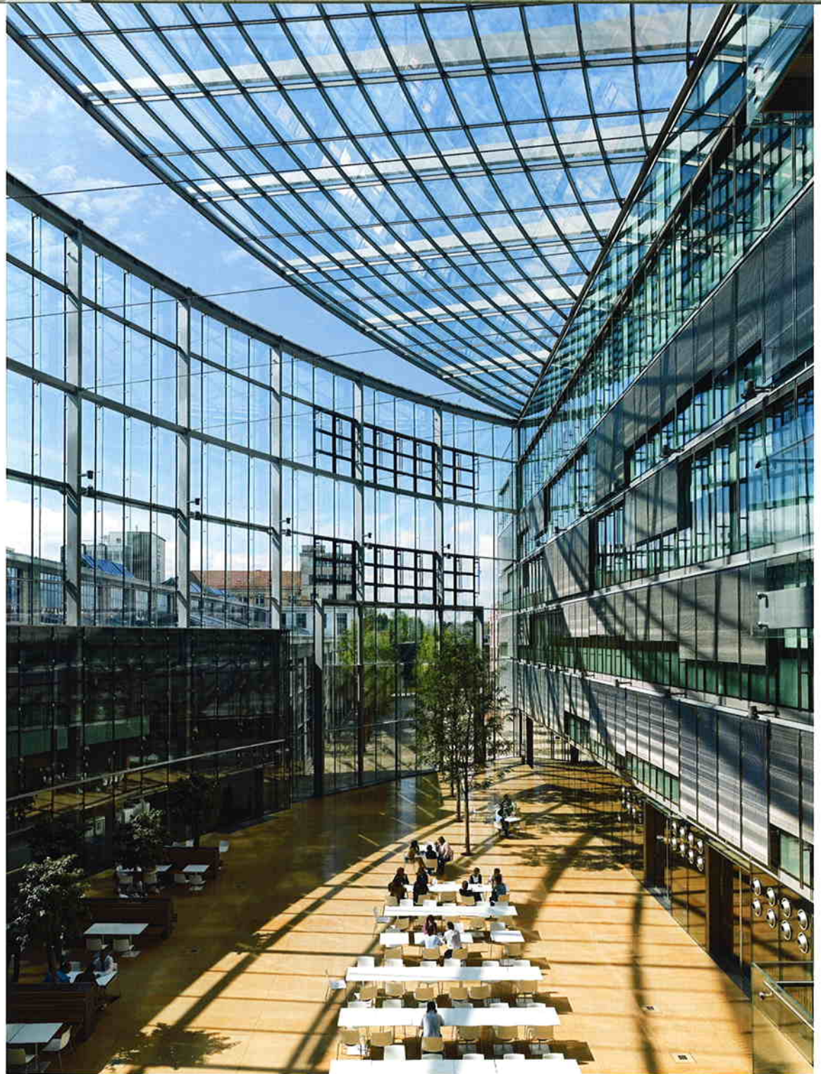
Le plus grand toit ouvrant vitré du monde apporte de l'air frais dans le forum, qui sert de lieu de rencontre à tout le campus.
